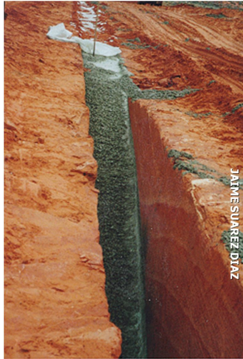
Figura 6.20 Pantalla impermeabilizante de concreto
