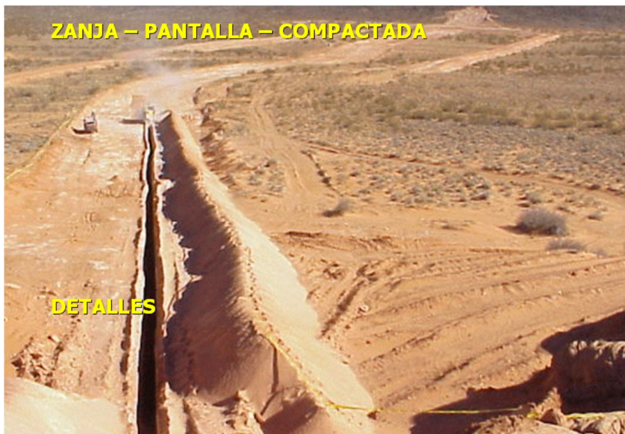
Figura 6.19 Material de desplante de una pantalla impermeabilizante
