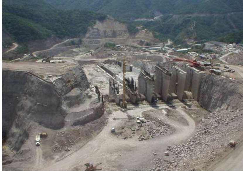
Figura 8.13 Obra de Excedencias en la Presa El Cajón
