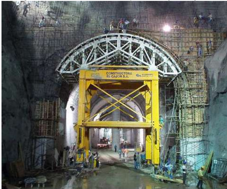
Figura 5.2 Portal de la Obra de desvío, presa El Cajón.
