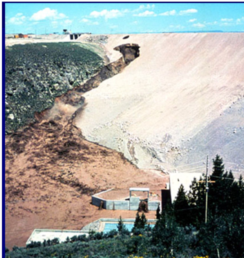
Figura 6.23 Falla de una presa por filtración en un estribo
