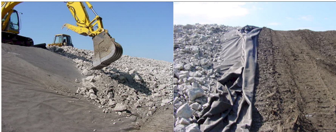
Figura 6.10 Protección de taludes utilizando enrocamiento.
