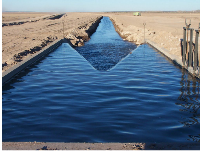
Foto 2.1 Vertedor pico de pato en Canal Sec. Norte (tomado de: http://www.panoramio.com/photo/48608909 )
