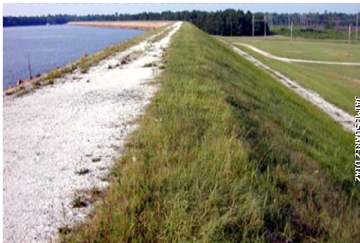
Figura 6.12 Protección de taludes utilizando pasto en el paramento seco
