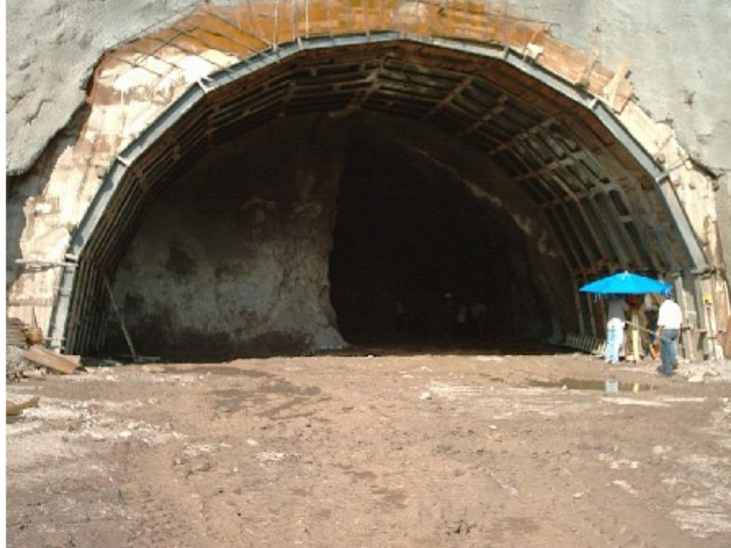
Figura 5.1 Obra de desvío de la presa El Cajón, Nayarit.
